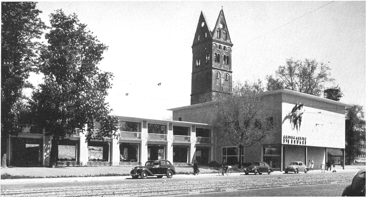
Gesamtansicht mit zerstörter Kirche St. Aposteln, rechts Vortragssaal, Mitte großer Lesesaal. Stahlskelett und Muschelkalkplatten | Vue générale prise du sud | General view from south Photo: H. Schmölz, Köln
