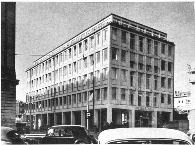
Gebäude der Basler Transport-Versicherungsgesellschaft in Frankfurt a. M. Eisenbetonskelett, Verkleidung mit Trassfels-Kalksteinplatten. Stützenmaß 2,25 m. Arbeitsgemeinschaft G. Gottwald und G. Weber, Arch. BDA, Frankfurt a. M. | Bâtiment d'assurance | Insurance building Photo: A. Pfau, Mannheim
