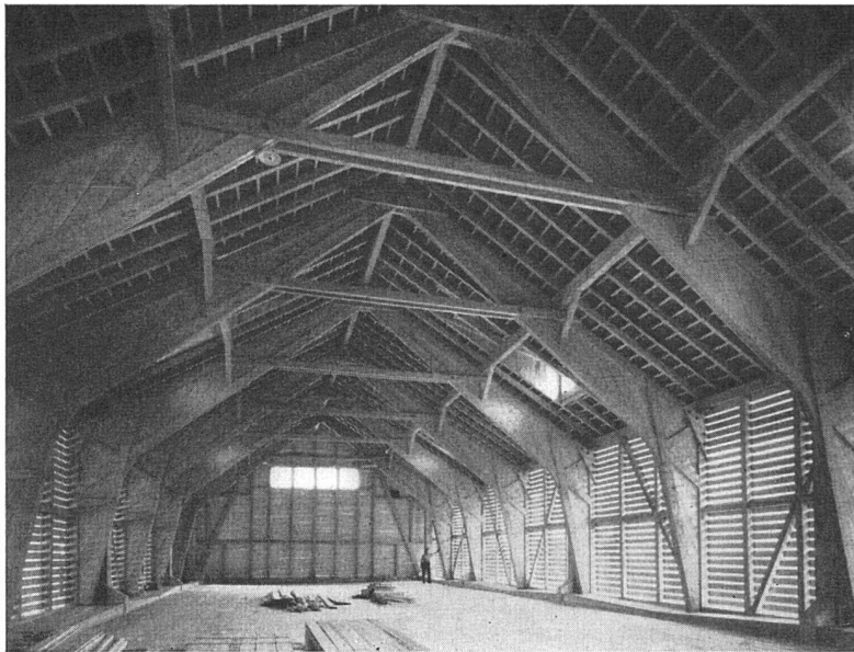
Ausstellung «Das Holz als Baustoff». Ökonomiegebäude in Cadenazzo (Tessin). Architekturbüro VSK, Basel. Ausführung Häring & Cie., Pratteln. Photo: Steinemann, Locarno
