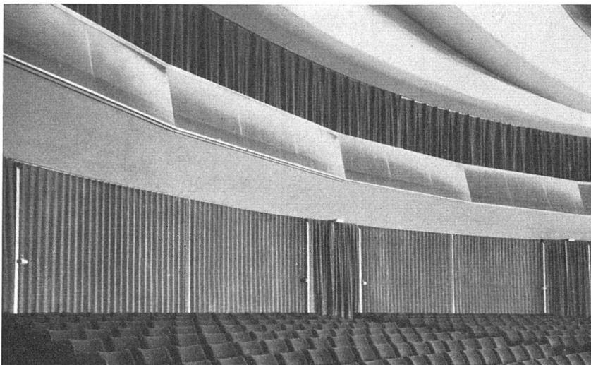
Gebogene Unterteilung von Saal und Vestibül im **Kino Le Plaza in Genf** durch Modernfold-Harmonikatüren. Die Velour-Vorhänge zwischen den Türen und auf dem Balkon sind auf gebogenen Kirsch-Bühnenschienen montiert.
