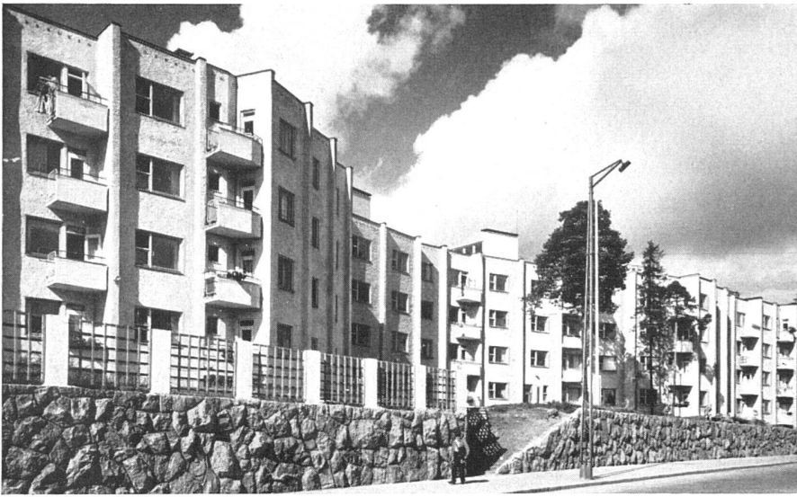
Wohnbaugruppe in Helsinki. Prof. Yrjö Lindegren, Architekt † | Immeubles locatifs («maisons-serpents») | Low-cost apartments in Helsinki Photo: Havas, Helsinki
