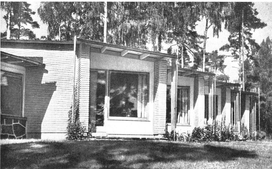
Ferien- und Klubhaus in Kansallis-Osake-Pankki, Apartmentflügel. Aarne Ervi, Olof Hansson, Architekten | Petit Hôtel et club | Holiday resort and club house
