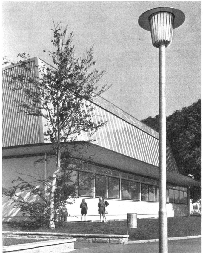
Außenansicht Turnhalle, Furalblech-Eindeckung / Extérieur de la salle de gymnastique / Exterior of gymnastic hall
