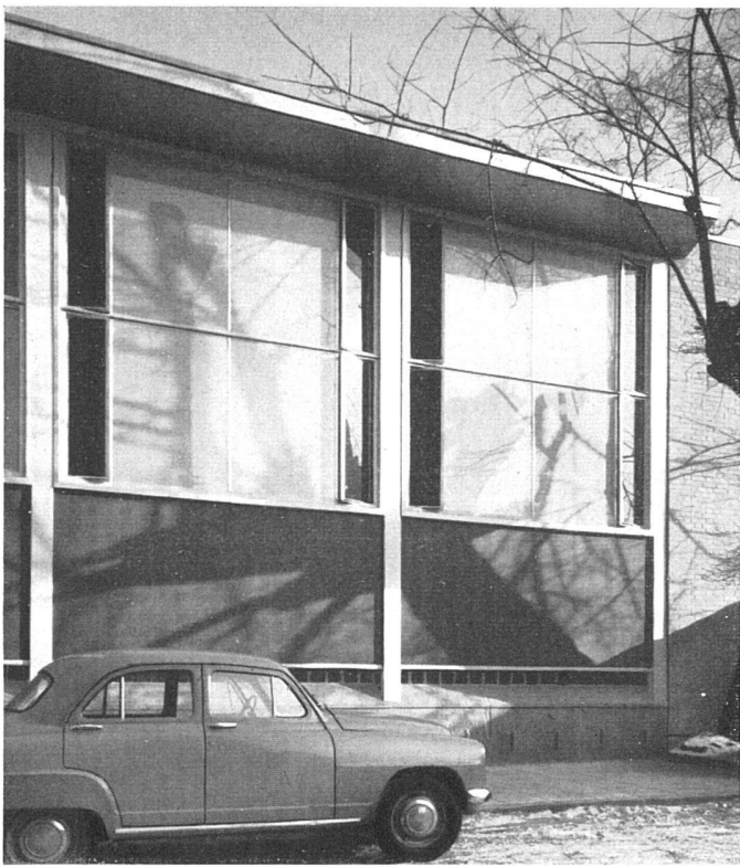
Fassadenausschnitt; Verkleidung, Spenglerarbeit und Fenster aus Aluminium | Détail de façade montrant l'emploi multiple de l'aluminium | Elevation detail showing the manifold use of aluminium
