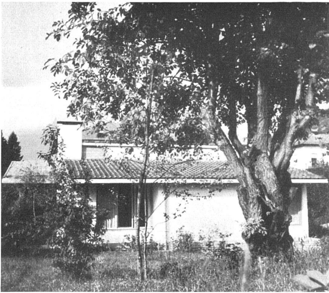
Haus A von Süden | La maison A; vue prise du sud | The house A from the south
