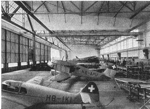
Werfthalle Flughafen Zürich-Kloten
