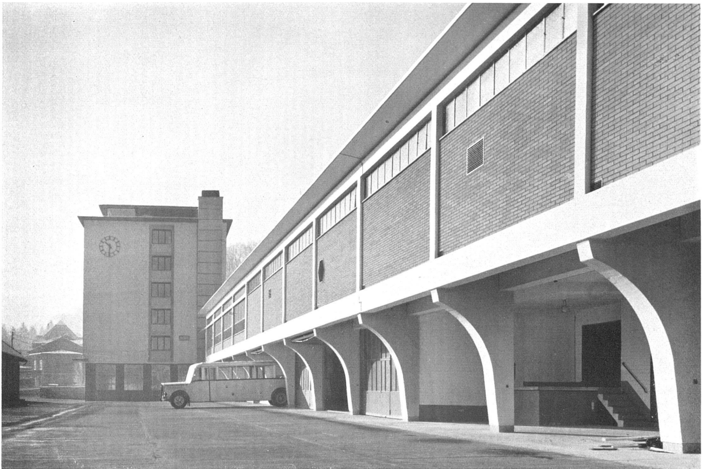
Garagebau, im Hintergrund der Südbau. Auskrugung des Obergeschosses aus Platzbedürfnis, dadurch gedeckte Passage im Erdgeschoß und Schutz der Garagetore / Le garage et l'immeuble abritant les bureaux; vue prise du nord-est / The garages and the office building from the north-east
