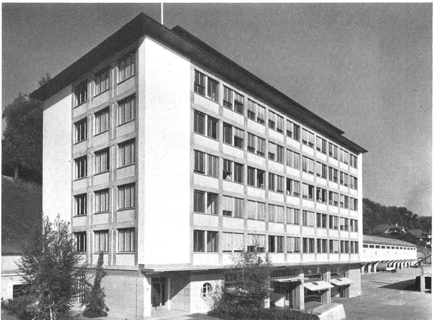
Südbau. Postcheck-Revisorat PTT 1.-5. Stock / Bâtiment abritant les bureaux des PTT / Office building from the south
