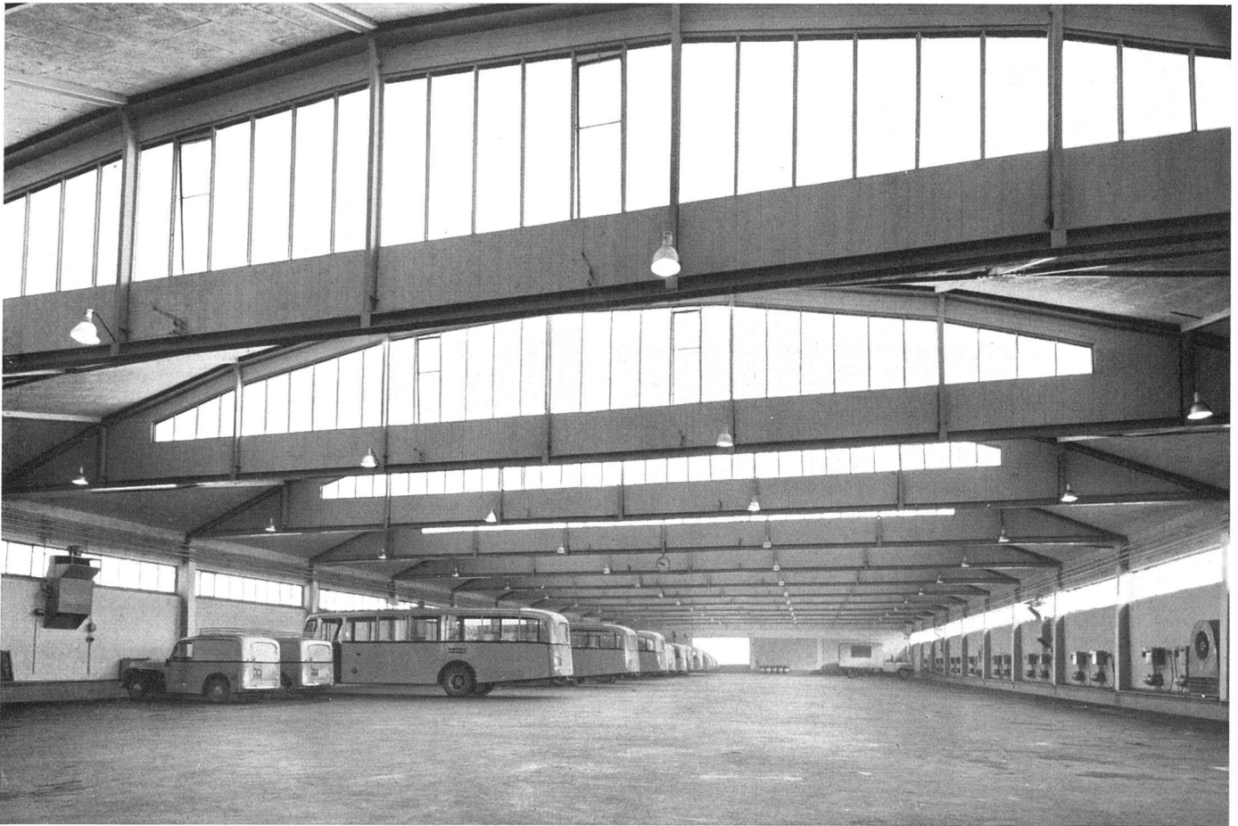
Größe stützenfreie Garagehalle; Spannweite 29 m, Länge 80 m – Sheds in Eisen gegen Norden. Rechts an der Wand Ladebatterien | Le grand garage | The garages Photos: Henn SWB und Meyer, Bern
