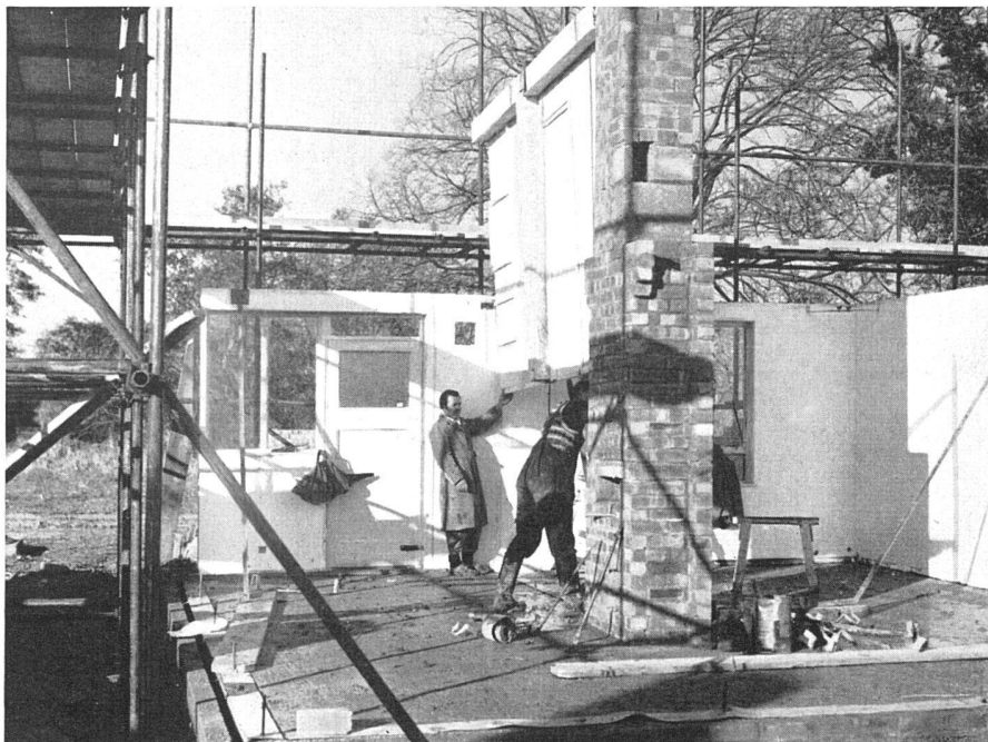
Arbeiten im Innern eines Hauses / Montage à l'intérieur d'une maison / Interior erection of a house
