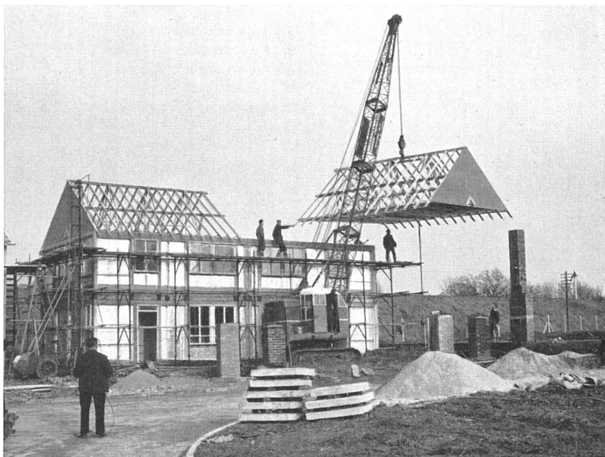
Ein Dachstuhl wird aufgesetzt / Le faitage d'une maison est monté / Erection of a roof unit
