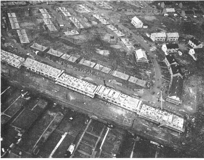
Die Siedlung während der Ausführung / La colonie en voie de réalisation / The houses under construction
