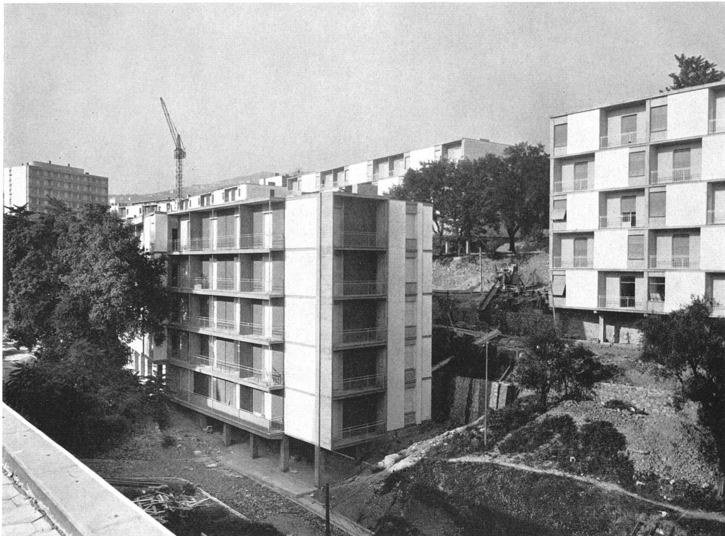
Blick von Süden mit den Wohnbauten 11, 9, 8, 3 und dem Hochhaus 2 / Vue, prise du sud, des immeubles 11, 9, 8, 3 et de l'immeuble à multiples étages 2 / General view from the south, showing blocks of flats 11, 9, 8, 3 and the multi-storey block 2
