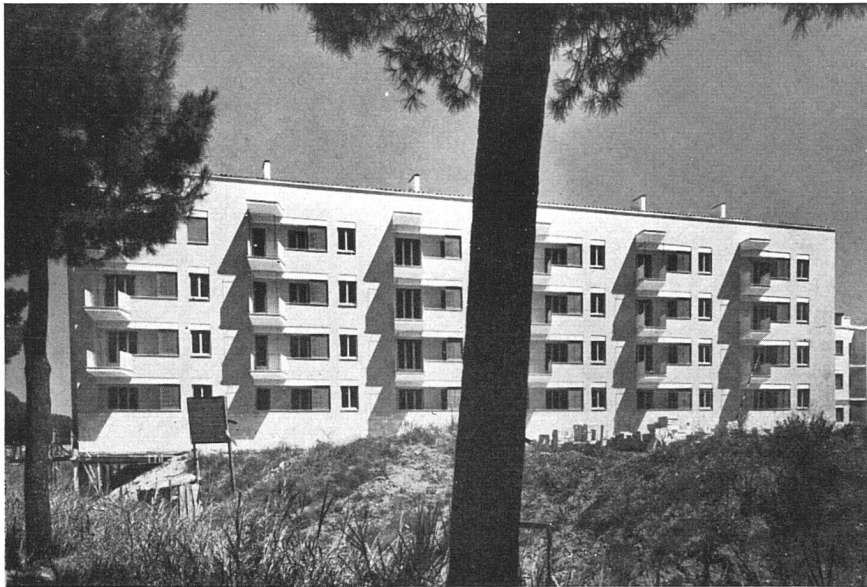
Wohnblock B, von Süden. Architekt M. De Renzi | Immeuble B; vue prise du sud | Block of flats B, from the south
