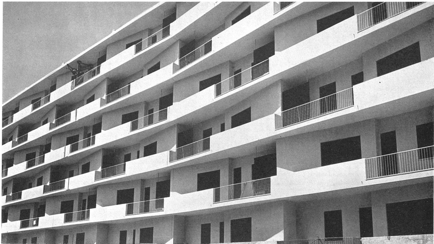
Wohnbau in der Nähe des Wohnquartiers «Tuscolano»; Fassadenausschnitt. Architekt M. Castellazzi | Immeuble locatif situé à proximité du quartier «Tuscolano»; détail de façade | Block of flats located in the neighbourhood of the Tuscolano quarter, elevation detail Photos: O. Savio, Rom
