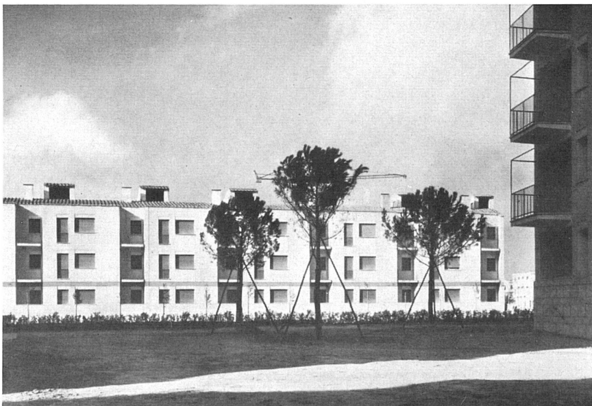
Wohnblock A von Süden | Immeuble A; vue prise du sud | Block of flats A, from the south
