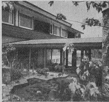
Schulhaus Matt in Hergiswil a. S. Architekten: W. H. Schaad SIA und E. Jauch BSA, Luzern
