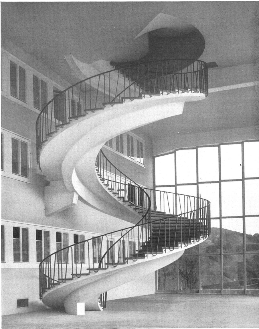
Die freitragende Spiraltreppe in der Wirtschaftshalle (Ing. SIA P. Sout- ter, Zürich) | L'escalier en colimaçon, hall de service | Spiral staircase, open service hall
