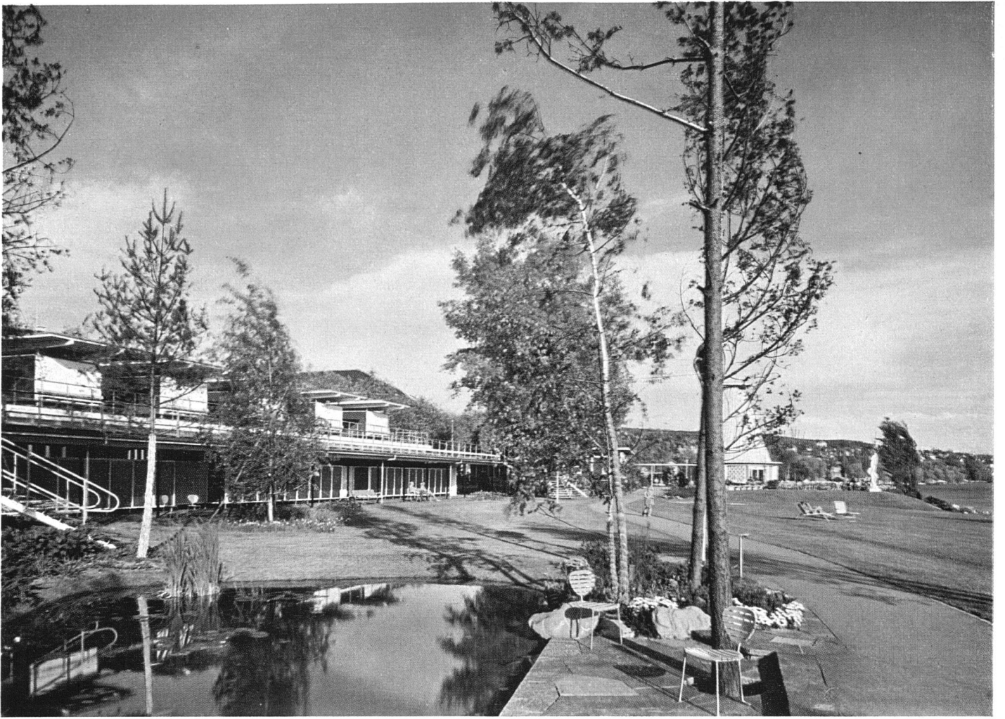
Männnergarderoben mit Blick gegen Teerestaurant | A gauche, vestiaires hommes; au fond, pavillon-restaurant | Men's cloakrooms towards the tea pavilion Farbphoto: Walter Binder, Zürich
