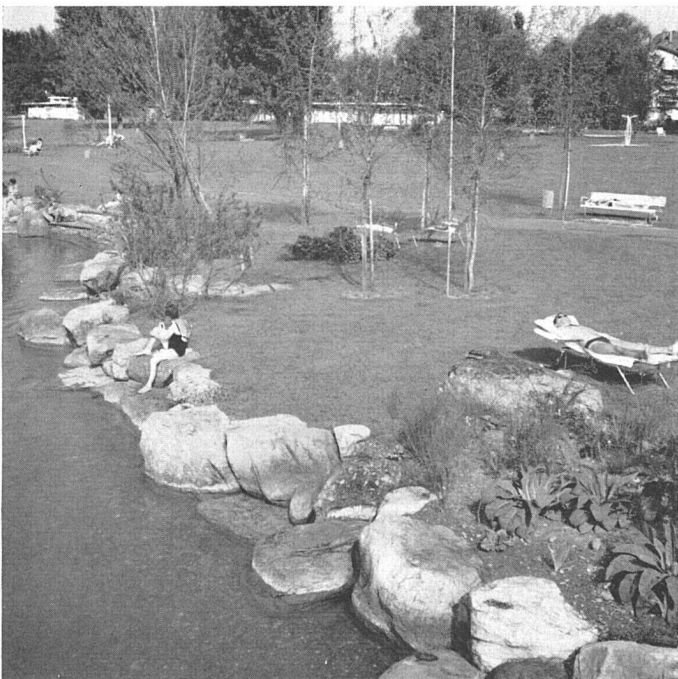
Uferpartie mit in Beton verankerten Steinblöcken | Détail de la rive | Lake bank, detail
