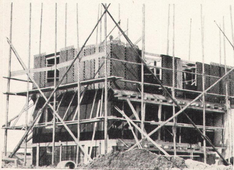
bei gleichem Grundriss! Durch die Verwendung vorfabrizierter BAUKORNAT-Fassadensteine liess sich z. B. der Nutzraum eines Einfamilienhauses um 6 m<sup>2</sup> vergrössern. BAUKORNAT-Fassadensteine sind leicht und von hervorragender Isolierfähigkeit. Die Betonfüllung lässt grosse Belastungen zu. Niedrige Heizkosten - gesundes Raumklima!
