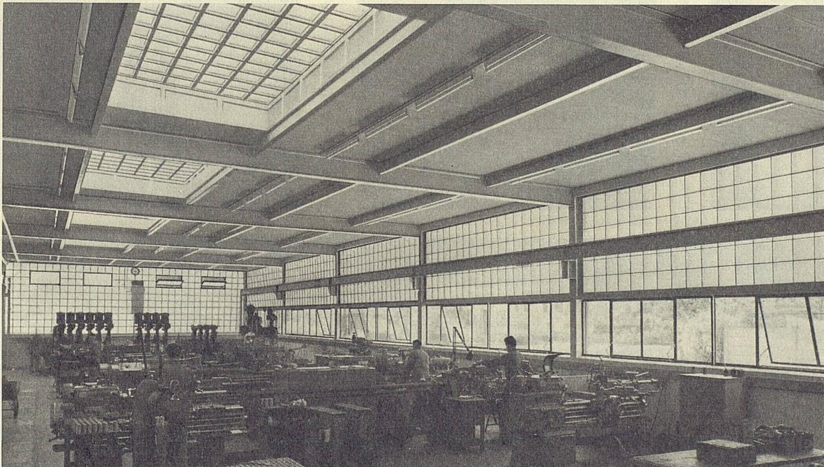
Innenansicht einer feinmechanischen Werkstätte • Maximale Raumausleuchtung und beste Isolation • Wände mit Funktions-Glasbausteinen • Decke mit SKYTROL-Steinen und elektrischer Heizung • Fensterband mit ISOLIERVERGLASUNG
