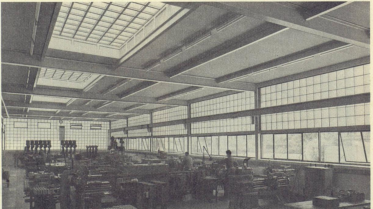
Innenansicht einer feinmechanischen Werkstätte • Maximale Raumausleuchtung und beste Isolation • Wände mit Funktions-Glasbausteinen • Decke mit SKYTROL-Steinen und elektrischer Heizung • Fensterband mit ISOLIERVERGLASUNG
