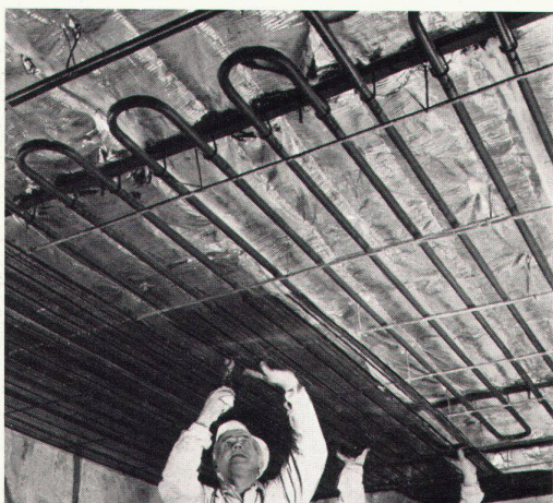
Sulzer-Hohlraumheizung mit frei verlegten Rohrschlangen während der Montage
