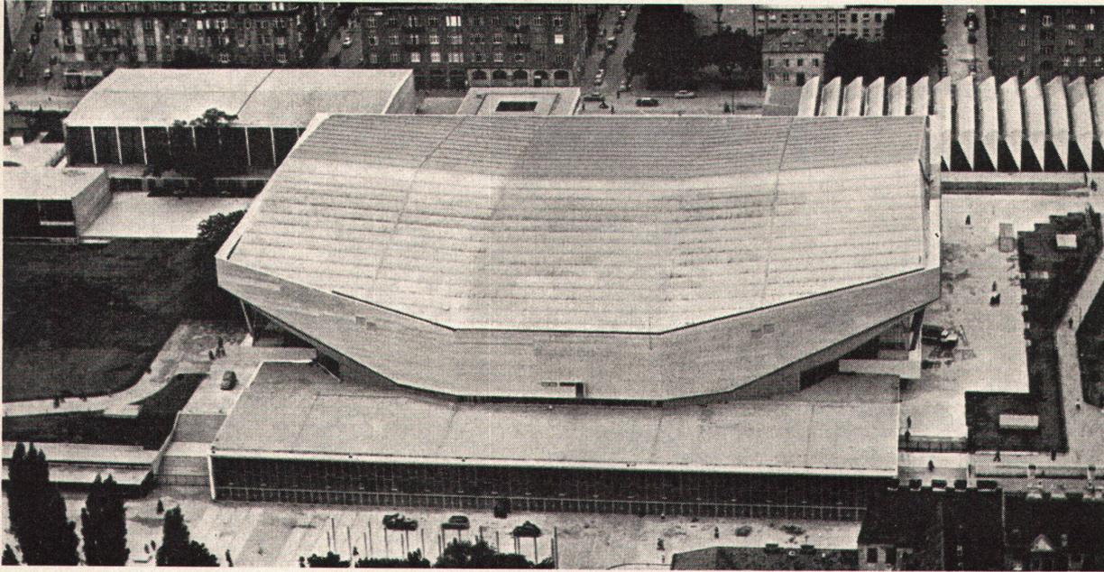
Wiener Stadthalle PLASTOCRETE-Betonzusatz für die Stahlbetonkonstruktion
