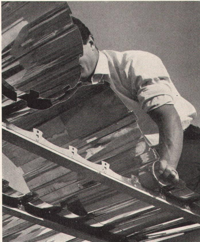
EDAK-Profile für Säulen-, Fassaden- und Wandverkleidungen usw.
