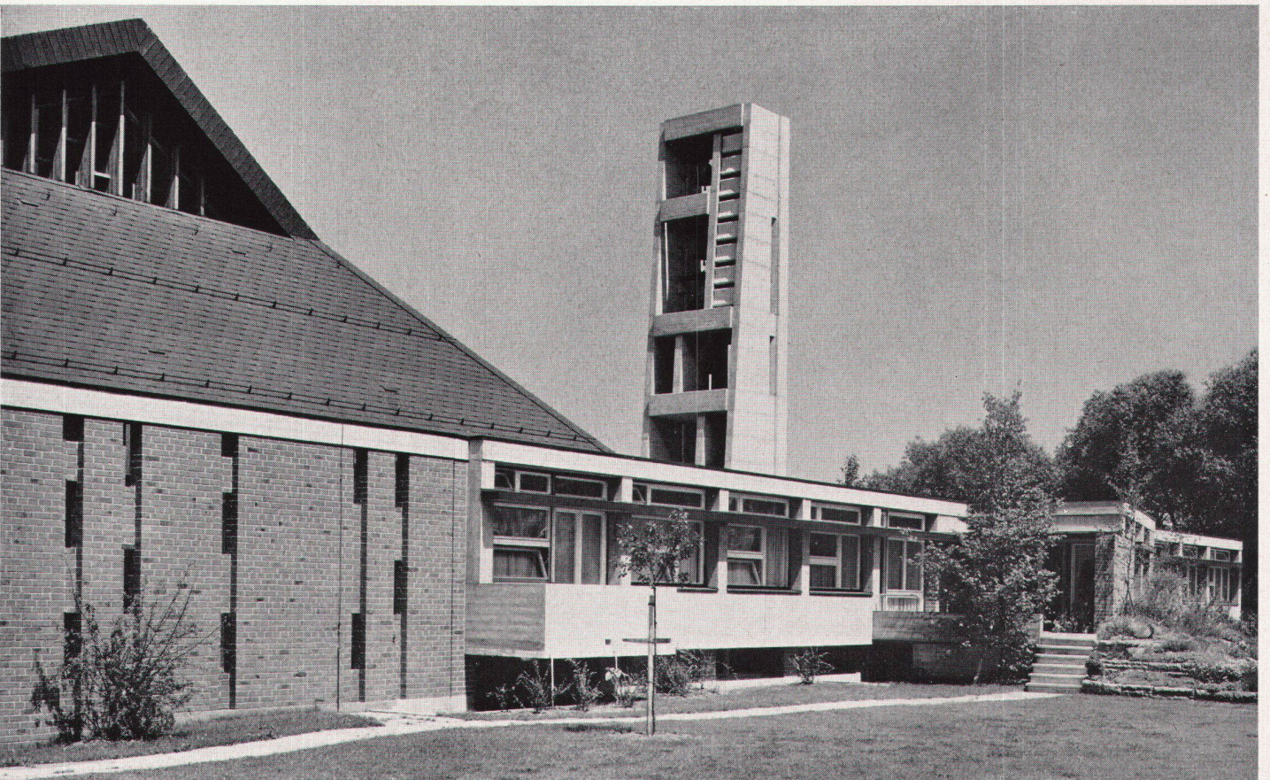
5 Südseite mit Pfarrhaus und Sigristenwohnung La cure et l'appartement du sacristain South elevation with rectory and sexton's lodgings
