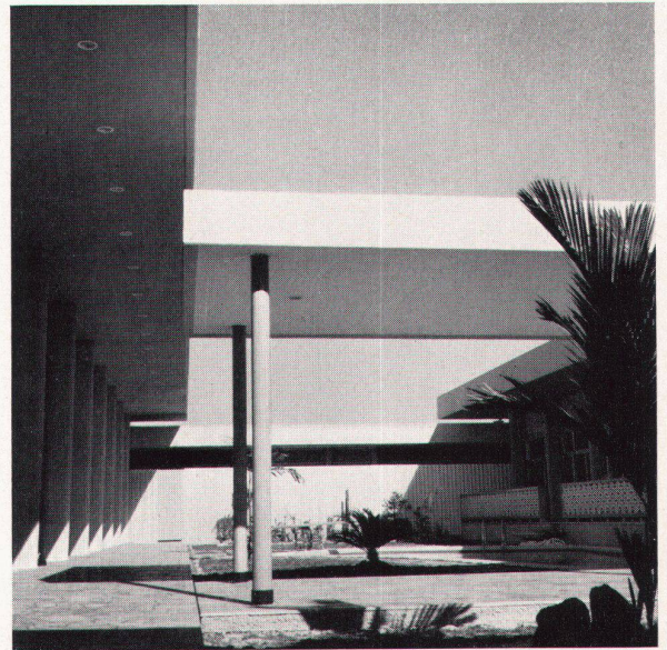
4 Innenhof der Kanzleien, Teiche für Luftkonditionierung; im Hintergrund Abwartwohnung Cour intérieure de la chancellerie, pièces d'eau pour le conditionnement de l'air; au fond, l'appartement du gardien Chancery patio, ponds for air conditioning; caretaker's lodgings in the background
