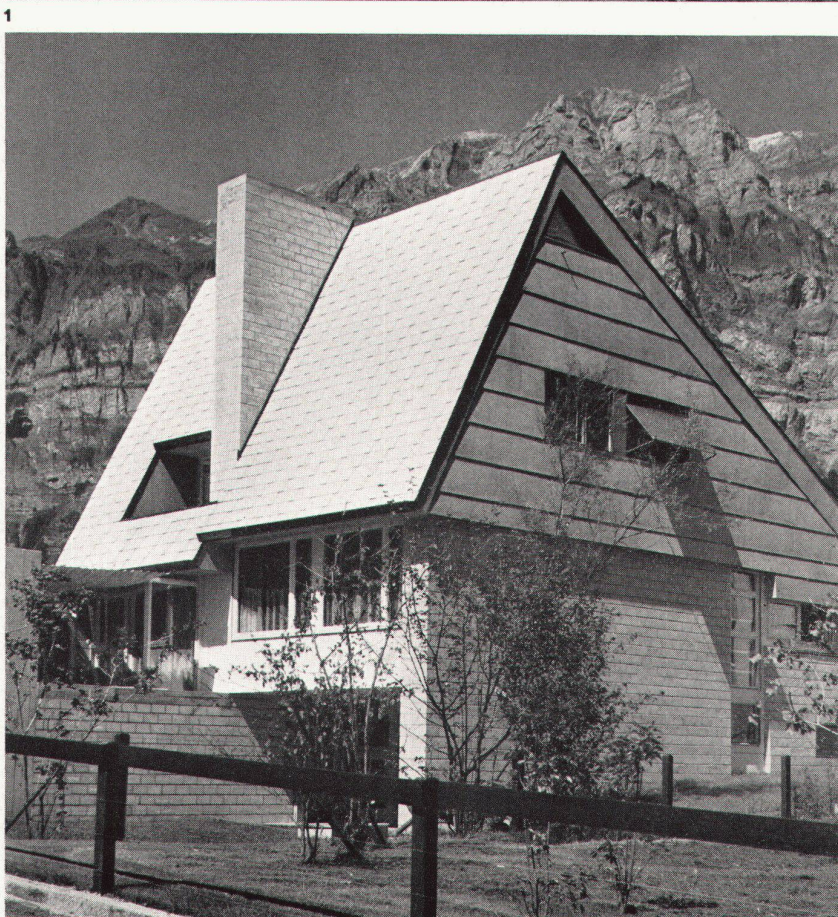
1 Ansicht von Süden Vue prise du sud View from the south
