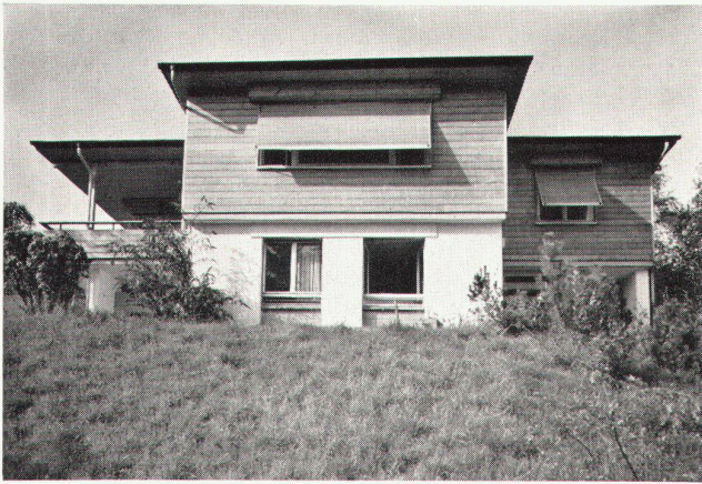
5 Wohnhaus am Ägerisee, erbaut für Henry van de Velde, 1957
