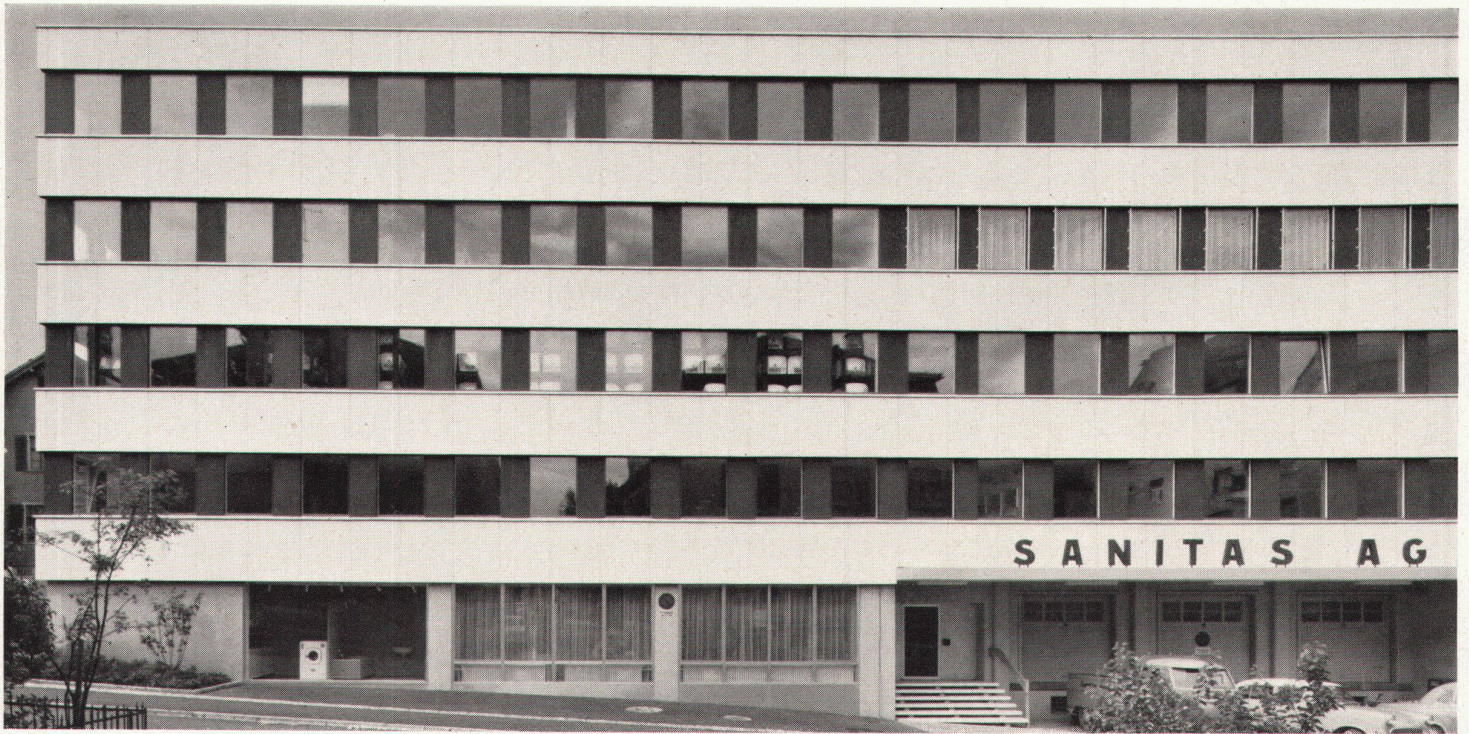
Eternitfassaden System Keller
