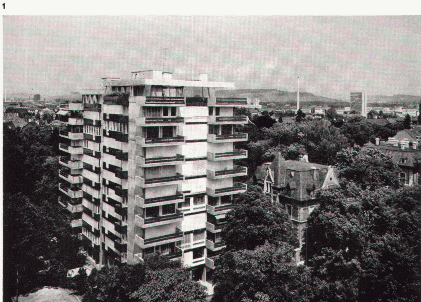
1, 2 Ansicht von Südosten Vue prise du sud-est View from the southeast
