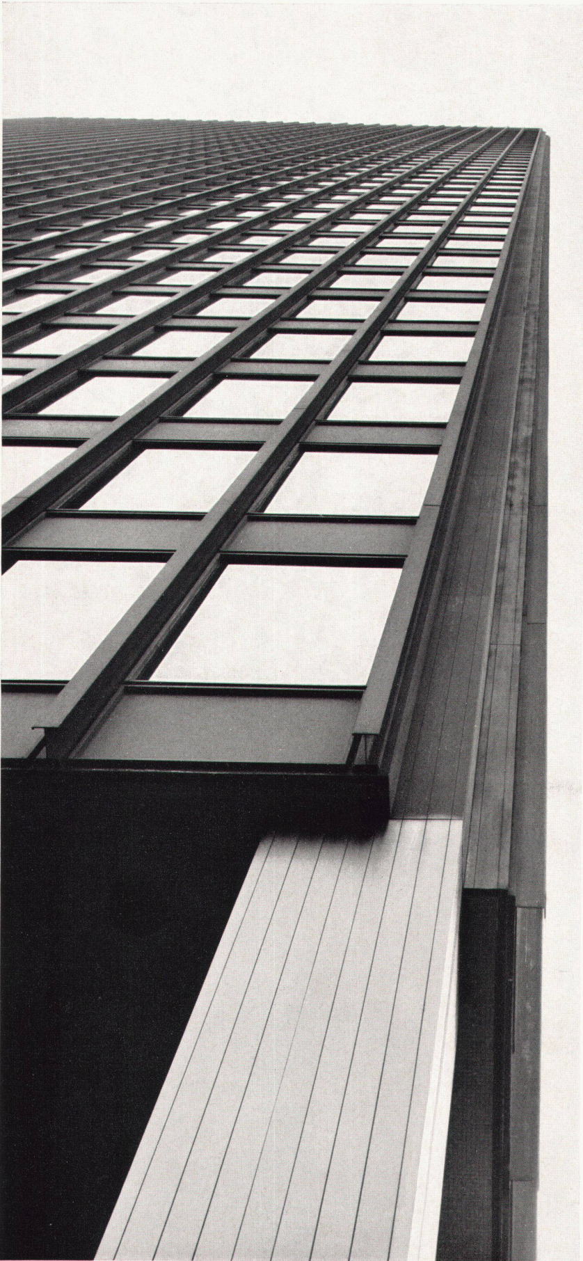
22 Vorgehängte Curtain-Wall-Fassade mit Bronzeverkleidung Façade-rideau recouverte de bronze Bronze-faced curtain-wall façade
