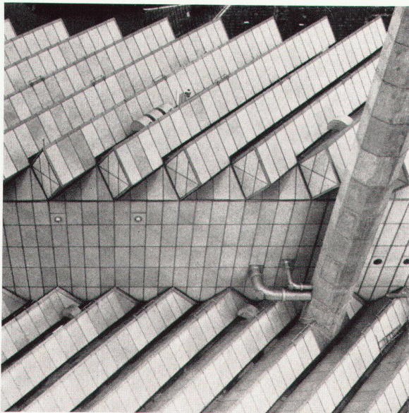
14 Wand- und Deckenteile der Werkstatt Détail des parois et plafonds de l'atelier Detail of wall and roof to workshops
