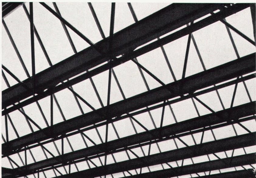
17 Dach zum nördlichen Licht vor der Verglasung Toit avec fenêtres «nord» encore sans verres Roof with northern exposure before glazing is in position
