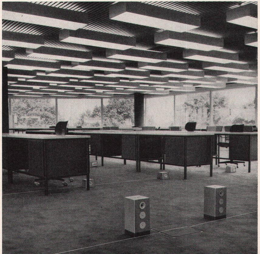
Teli-Flur, das Elektro-Installations-system in Fußboden und Fensterbankkanal, ist der Träger aller Leitungswege für Stark- und Schwachstrom. Der Teli-Flur-Kanal kann auch Jahre nach dem Einbau an jedem beliebigen Punkt angebohrt und das Verteilsystem dadurch ergänzt oder geändert werden, weshalb eine weitgehende Flexibilität in der Raumnutzung gewährleistet ist.
