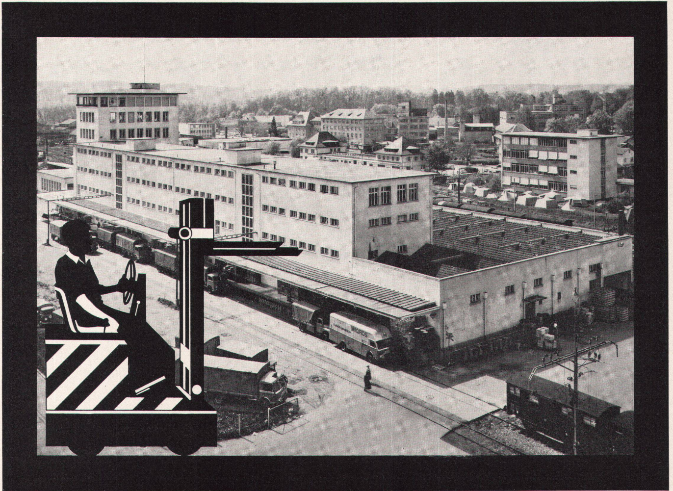
Migros-Lagerhaus, Bern: Klimaanlage der WERA AG
