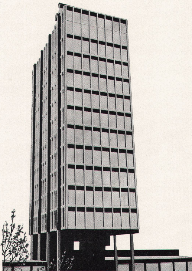
Imprimeries Réunies - Lausanne. Architekt: J.-M. Lamunière
