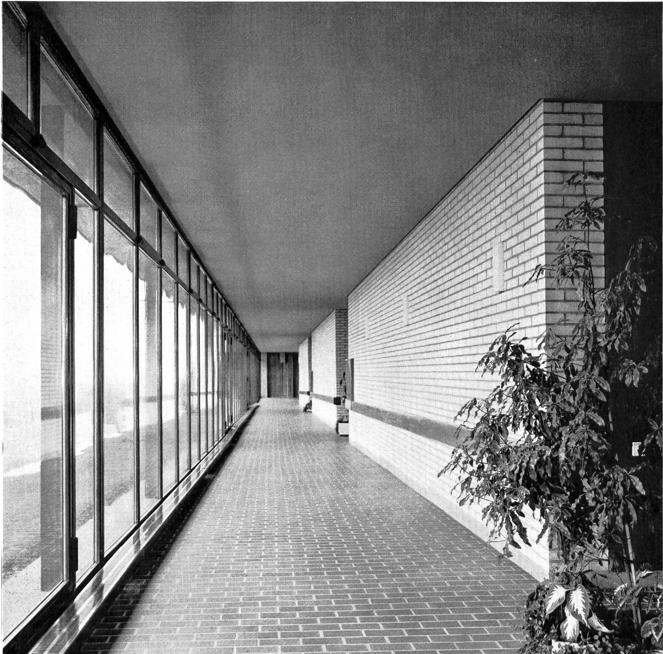
Glatte, heruntergehängte Decke aus Gitro-Platten
