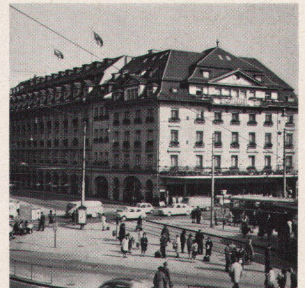
Gebr. Loeb AG, Bern • Starkstromanlagen (Licht, Kraft, Wärme) • Notstromversorgung • Telefonanlage • drahtlose Personensuchanlage HASLER • Gegensprechanlage • Uhrenanlage • Blitzschutzanlage/Projektierung und Installation
