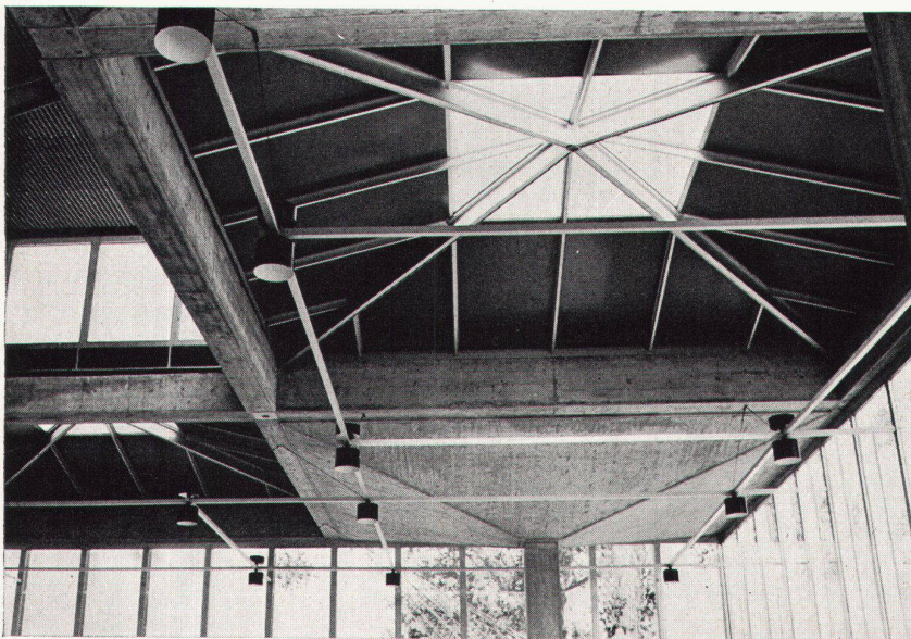
1 Gesamtansicht Vue générale General view
