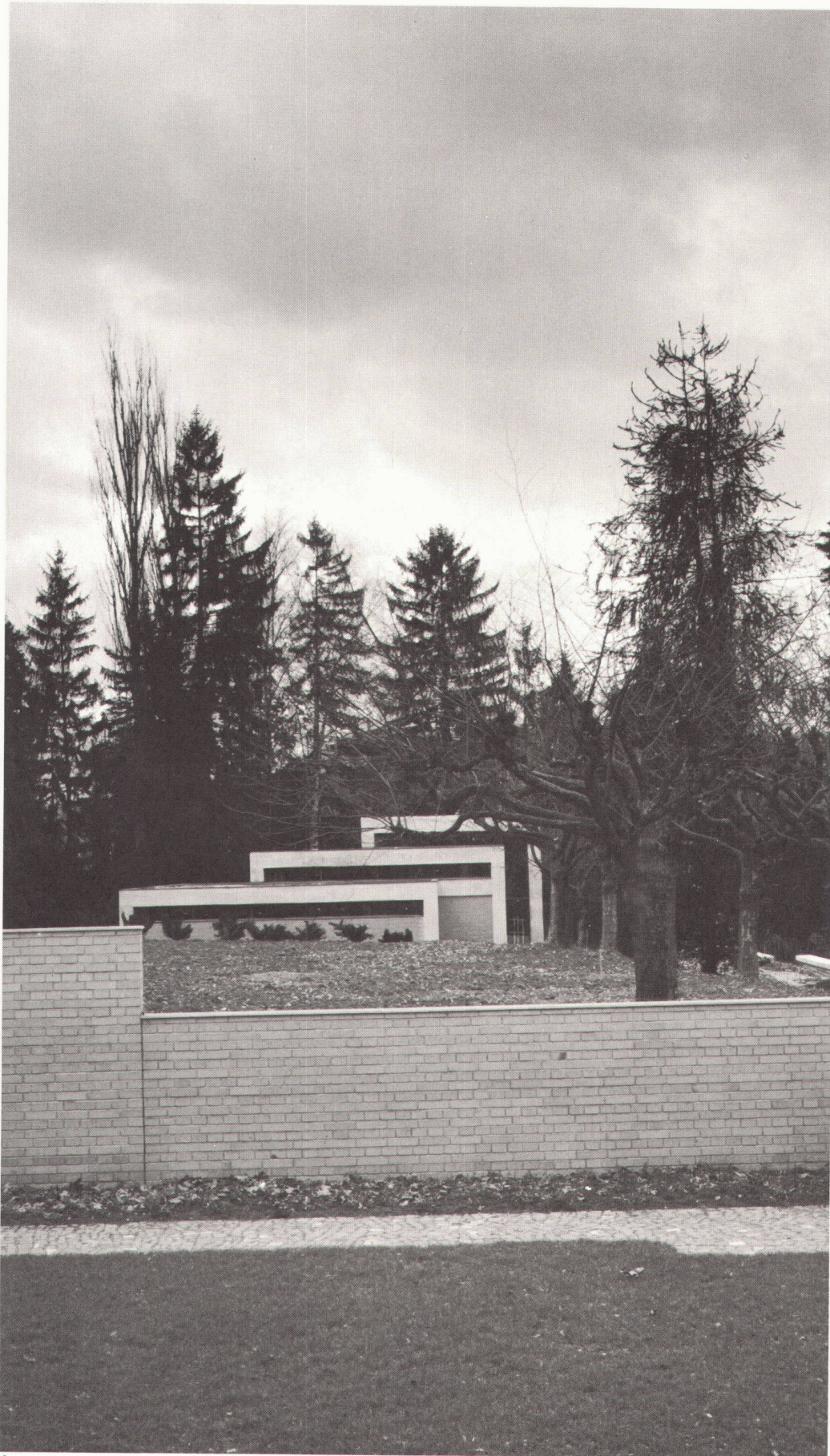
4 Kombination der Dachflächen bei der Abdankungshalle; im Vordergrund die Backsteinmauern des Kinderfriedhofs Halle funéraire: aménagement des toitures planes; au premier plan, le mur en briques brutes du cimetière des enfants Combination of roof surfaces on funeral hall; foreground, the brick walls of the children's cemetery
