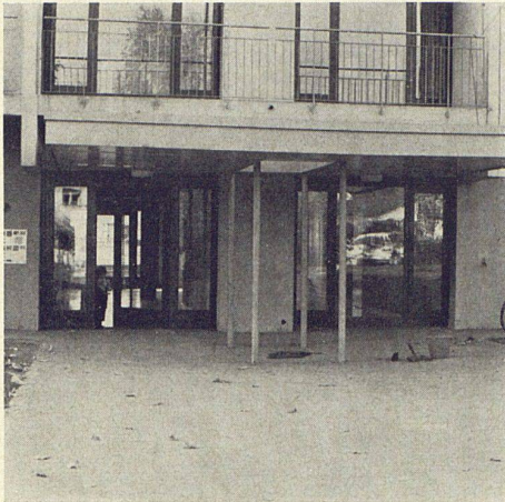
6 Haus 1: Eingang mit Vordach, dahinter Eingangshalle
