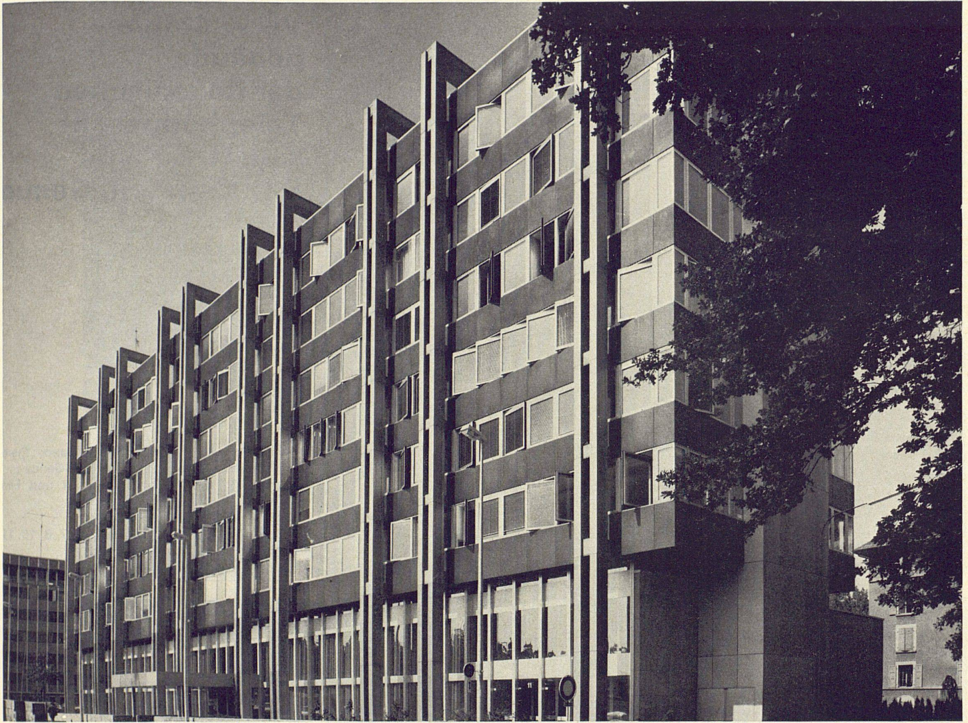
5-7 Die von der Fassade abgesetzten Doppelpfeiler erscheinen im Erdgeschoß im Innern des Gebäudes. Die Pfeiler und die gerippten Decken sind aus Eisenbeton, die Pfeiler mit Aluminium verkleidet; die vorgehängten Fassaden aus Aluminium und Glas sind an den Deckenfronten befestigt
