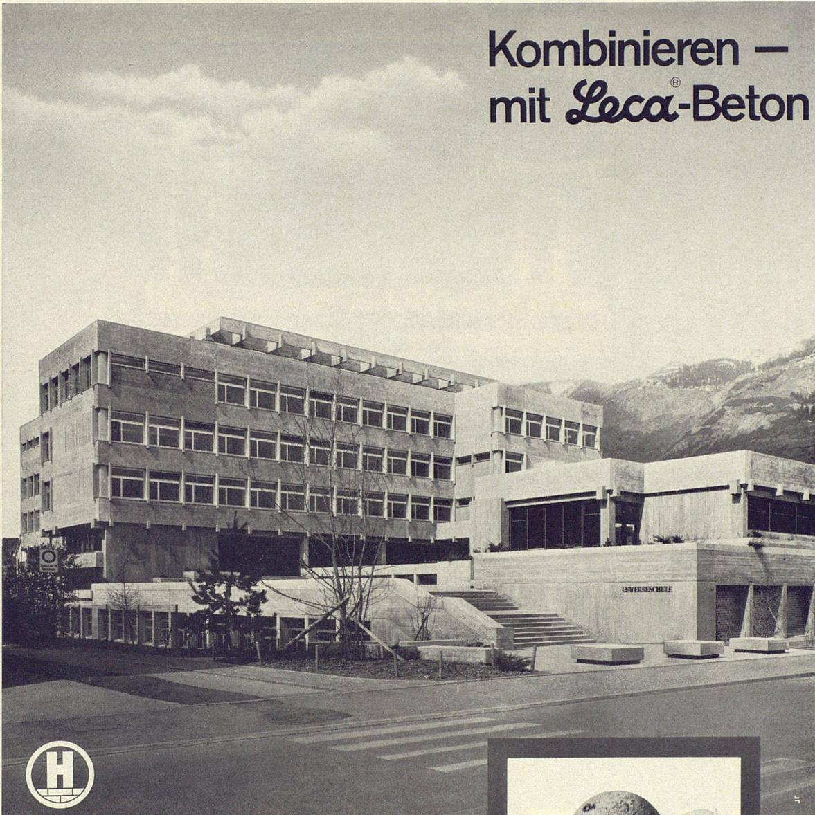
Gewerbeschulhaus Chur; seine Fassaden und Dachaufbauten sind — teils an Ort geschüttet, teils vorgefertigt — in *Leca*- und Normalbeton ausgeführt.
