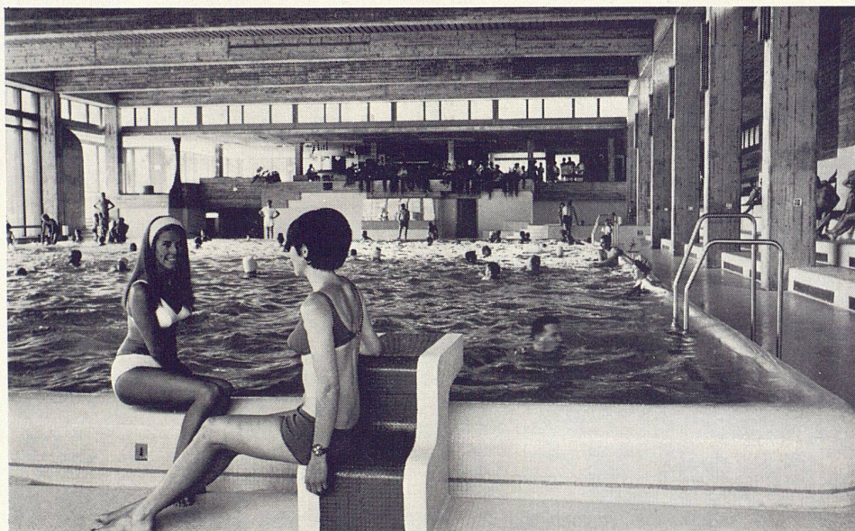
Objekt: Neubau Hallenbad St. Moritz Projekt und Bauleitung: Architektengemeinschaft R. Obrist + A. Theus, St. Moritz
