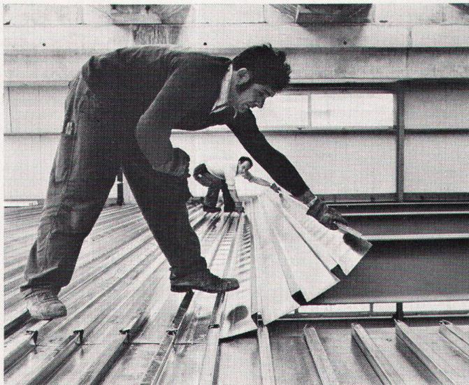
Praktisch, weil selbst das Deckenproblem gelöst ist. (Holorib kann gespritzt werden, oder heruntergehängte Decken werden an dem Holorib-Profil montiert.)
