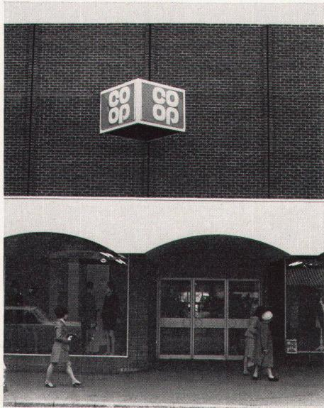
Die freien Räume des Konsumvereins in Bournemouth zeigen die silbern angemalte tragende Betondecke, die teilweise mit einem untergehängten orangefarbenen Gitter versehen ist. Die Außenfassade ist Backstein, die Untersicht der Gewölbe des Eingangs gestrichenes Holz.
