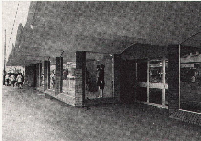
*Les locaux libres de la société coopérative de Bournemouth laissent apparaître la dalle portante en béton, au ton argenté et supportant en partie une grille orange, librement suspendue. La façade est en briques, la voûte d'entrée est revêtue de bois peint du côté intérieur*
