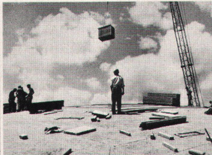
Buckelschalung mit Perfecta-Platten
