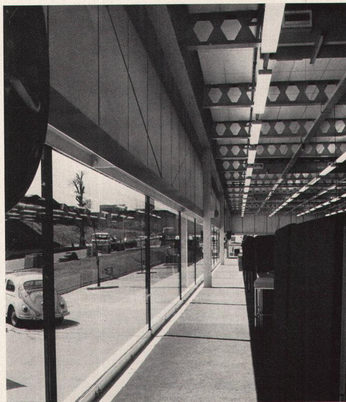
Für den Forschungs- und Bürobau der Computer Technology Ltd in Hemel Hempstead haben die Architekten, ähnlich wie bei der vorangegangenen Publikation (S. 332–334) ein flexibles Stahlbausystem angewendet. Sperrholzplatten, beidseitig mit Aluminium verkleidet, bilden den oberen Teil der Fassaden. Isolierung der Fugen mit Neopren-Profilen
