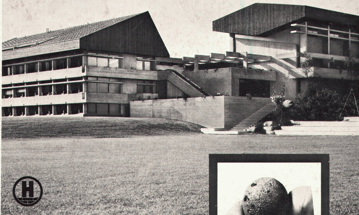
Oberstufenschulhaus «Buchen» in Speicher aus Leca -Beton mit Sichtstruktur Planung: H. P. Nüesch, Architekt BSA/SIA, St. Gallen; Mitarbeiter: H. Walser Statik: Ch. Wieser, dipl. Ing. ETH/SIA, St. Gallen Bauausführung: Otto Bruderer, Bauunternehmung, Teufen
