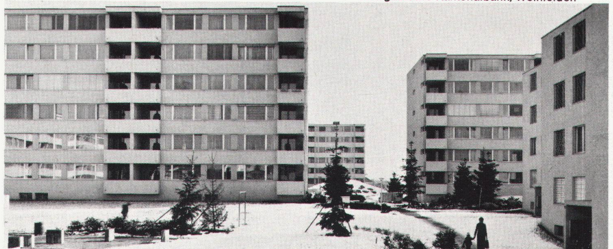
Überbauung Rain, Jona SG
