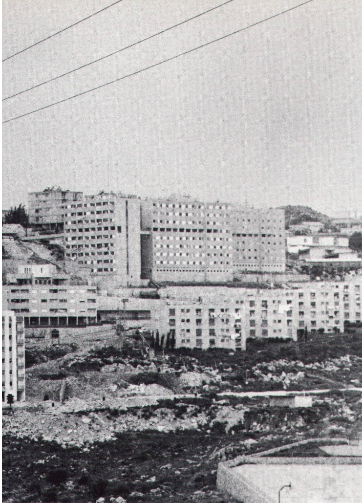
1 Überbauung im Südwesten von Jerusalem (Kiryat Hayovel) 2 Notunterkünfte für Neueinwanderer (Katamon) 3 Wohnblöcke in Kiryat Hayovel
