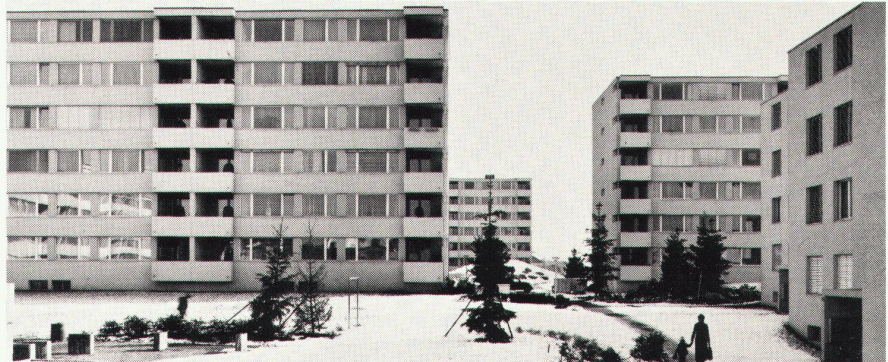
Überbauung Rain, Jona SG
