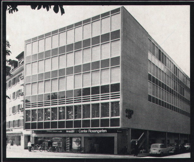
Geschäftshaus-Center Rosengarten, Solothurn. Aluminium-Fassaden mit Modell HZ 750 und vollisolierten ALSEC-50-Fenstern.
