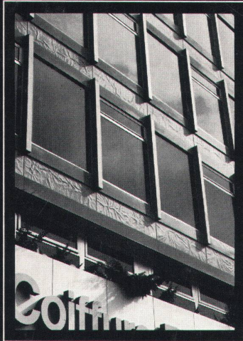
Geschäftshaus-Center Rosengarten, Solothurn. Aluminium-Fassaden mit Modell HZ 750 und vollisolierten ALSEC-50-Fenstern.
