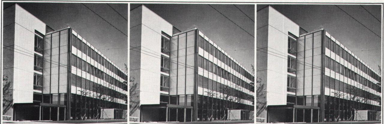
*Die Firma Geilinger (Geilinger & Co., Metallbau, Winterthur) lieferte Brüstungsverkleidungen (750m<sup>2</sup>), Stützenverkleidungen (380 Stück) sowie Leichtmetall- und Holz/Metall-Fenster (2400m<sup>2</sup>).*
